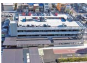
▲中央診療棟東側の立体駐車場
