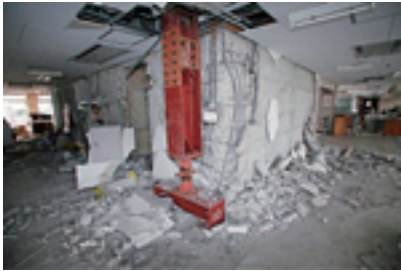
▲東日本大震災で大きな被害を受けた福島県須賀川市庁舎(昭和44年竣工)
