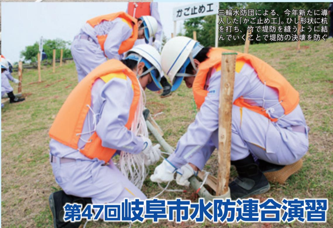
三輪水防団による、今年新たに導入した「かご止め工」。ひし形状に杭を打ち、竹で堤防を縫うように結んでいくことで堤防の決壊を防ぐ
