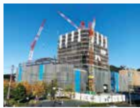
↑建設中の新庁舎(11月撮影)
