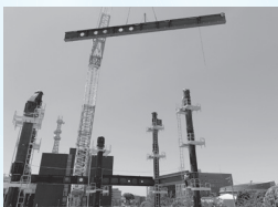
↑ H31年1月～：鉄骨工事
