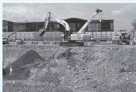
↑ H30年5～9月：掘削工事
