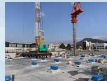
▲現場状況(基礎工事の終盤)
