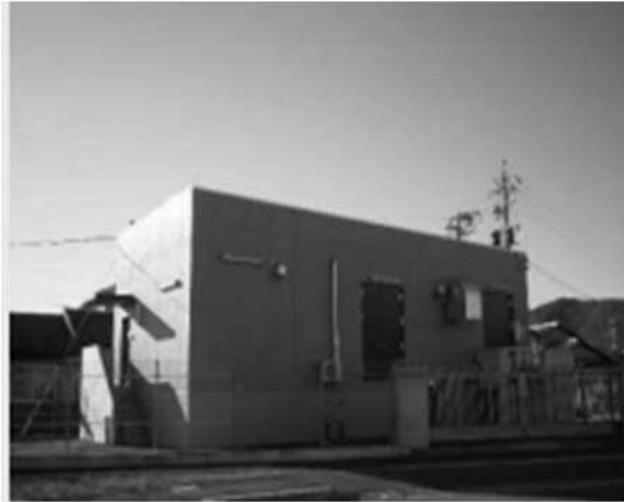
黒野第1加圧施設
