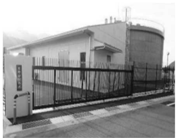
岩野田加圧施設
