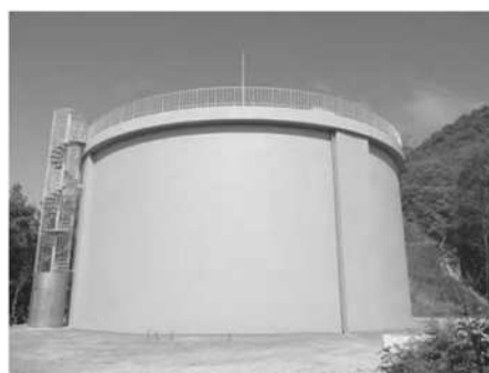
黒野第 1 配水池
