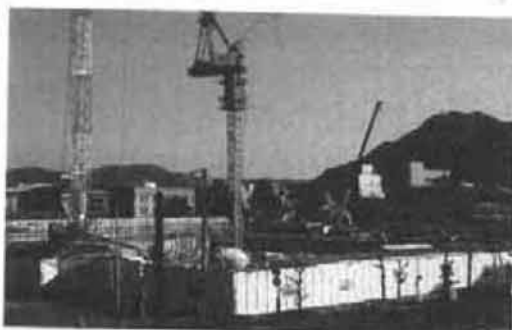
建設が進む新市庁舎 市民にとって使い勝手の良いものにする努力が求められる
