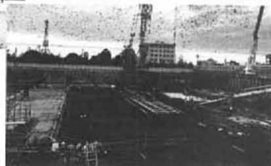
基礎工事の様子 (30年9月現在)
