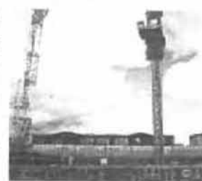
新庁舎建設現場(430.12.18)
