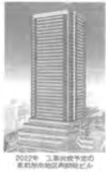
2022年 3層階完成予定の高鳥居南地区再開発ビル
