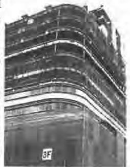
建設中の新市庁舎
