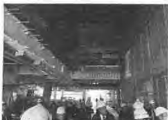
1階南(南側玄関)から入り北側(メディアコスモス)を見る。安全柵や防御ネットがあるとは言うものの吹き抜けがあり、かなり広く感じました。
