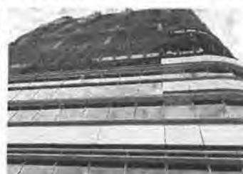
4階外の緑化施設(屋外デッキ)から建物を見上げた状況。
