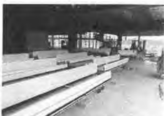
8階へ建築資材が運び込まれ工程順に置かれ準備されていました。
