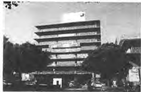
跡地利用が注目される岐阜市役所現庁舎
