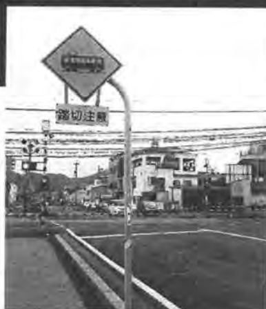
開かずの踏切解消へ。名鉄高架化事業
