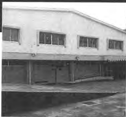
2024年度までにすべての小中学校体育館にエアコンが設置される
