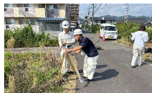
上水道・下水道管路測量
