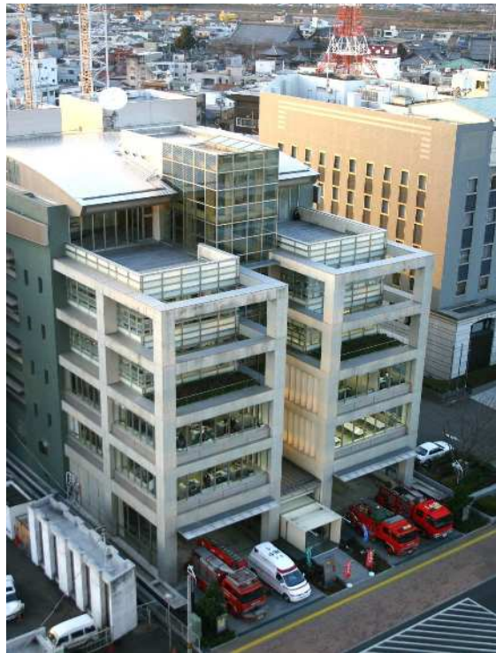
岐阜市消防本部・岐阜中消防署
