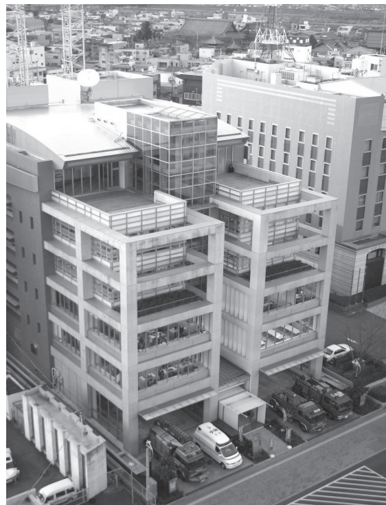
岐阜市消防本部・岐阜中消防署
