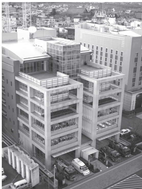
岐阜市消防本部・岐阜中消防署
