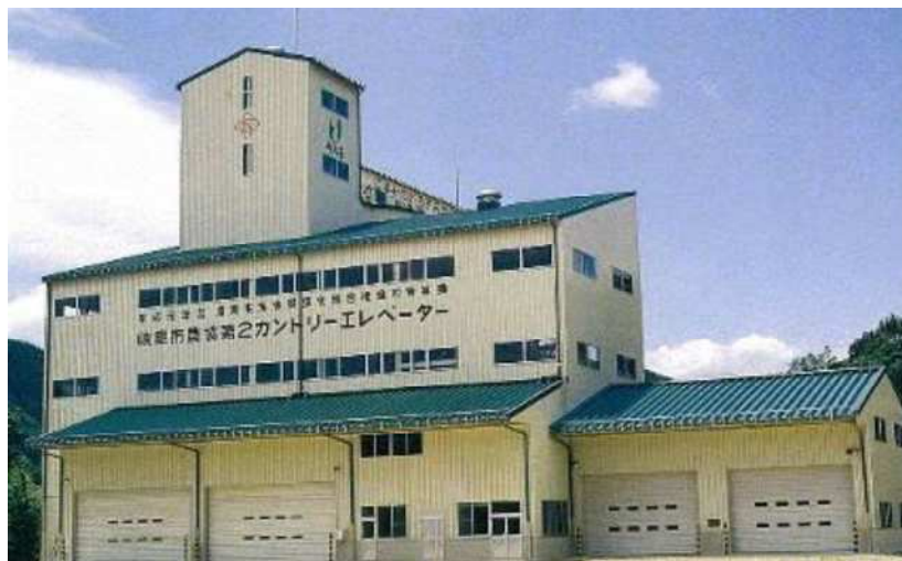
ぎふ農業協同組合第 2 カントリーエレベーター
