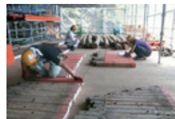
寸法・損傷調査
