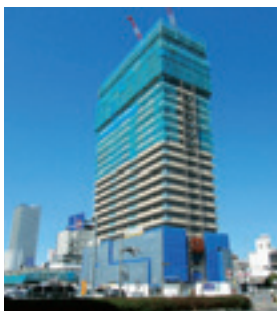
▲岐阜駅東工事状況 (平成30年3月現在)
