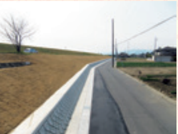
▲ドレーン工の整備事例
