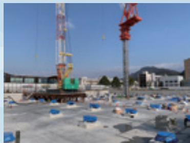
▲現場状況(基礎工事の終盤)
