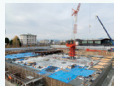
▲基礎工事の施工状況
