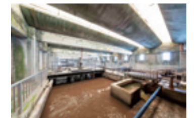
▲北部プラント(下水処理場)
