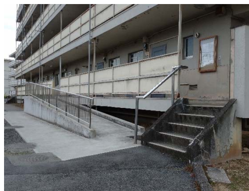
手すりやスロープの設置(大洞団地)
