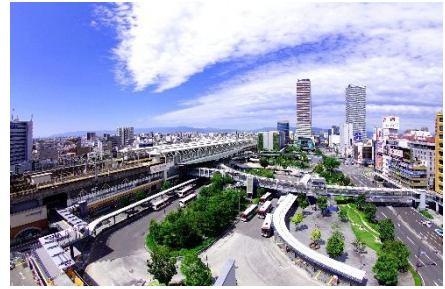
岐阜駅北口駅前広場
