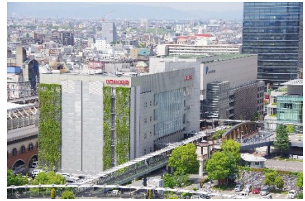
壁面緑化（じゅうろくプラザ）
