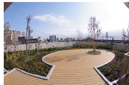
屋上緑化（岐阜イーストライジング 24）
