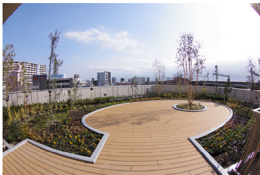
屋上緑化（岐阜イーストライジング 24）
