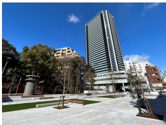
透水性コンクリート舗装 (金公園)
