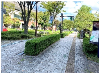
歩行者と自転車の空間を分離 (栄町竜田町線)
