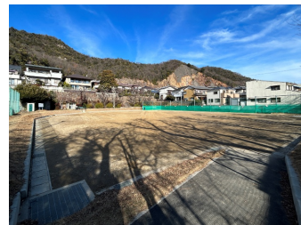
流域貯留施設 (沓掛公園)
