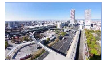
岐阜駅北口駅前広場
