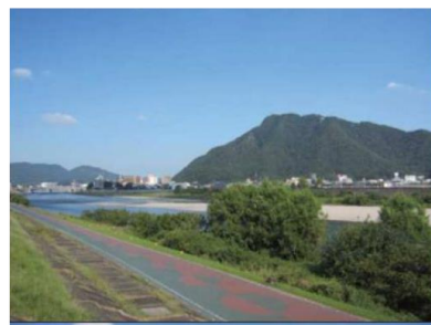
長良川堤防道路
