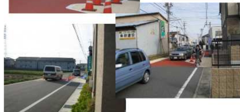
暫定的な狭さく部等の設置
