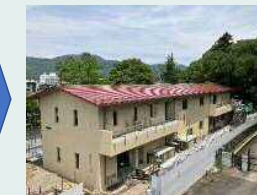
建設中の新管理棟 令和6年完成予定
