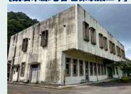
現在の管理棟 昭和48年竣工 (築50年)
