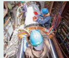
中部幹線バイパス管工事
