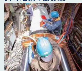
中部幹線バイパス管工事
