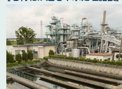
北部プラント 昭和41年供用開始 (築57年)
