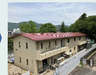
建設中の新管理棟 令和6年完成予定
