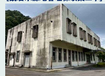
現在の管理棟 昭和48年竣工 (築50年)
