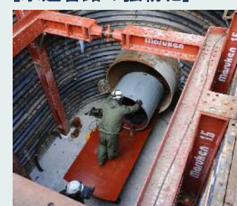
金華地区配水幹線布設替工事
