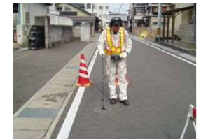
漏水調査の様子
