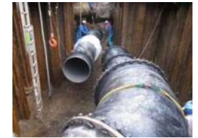
基幹管路の耐震化工事
