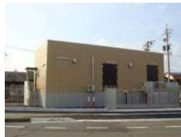
黒野第1加圧施設 (平成27年8月完成)
