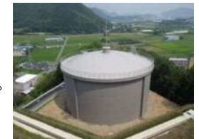
黒野第1配水池（容量4,000m 3 ） (平成26年12月完成)
