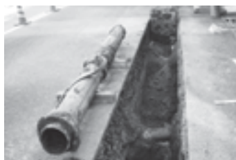
◀撤去された水道管 (口径200mm)
