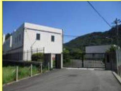
雄総水源地 設置年度：昭和46年
