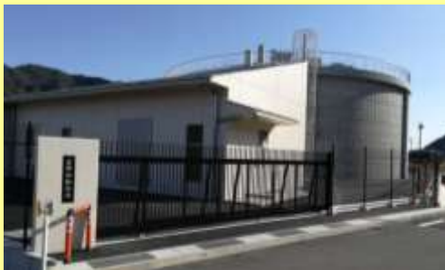
岩野田配水池 設置年度：平成30年3月
