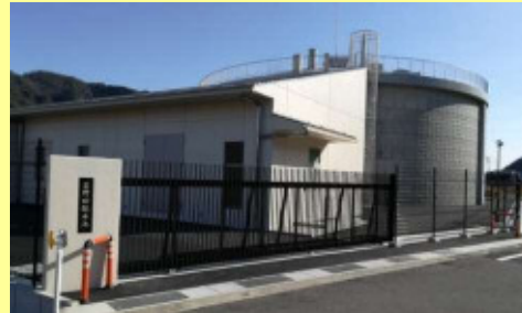
岩野田配水池 設置年度：平成29年
