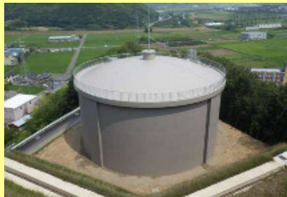
黒野第1配水池 設置年度：平成26年
