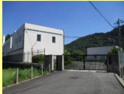
雄総水源地 設置年度：昭和46年
