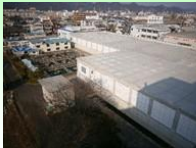
中部プラント改築工事
