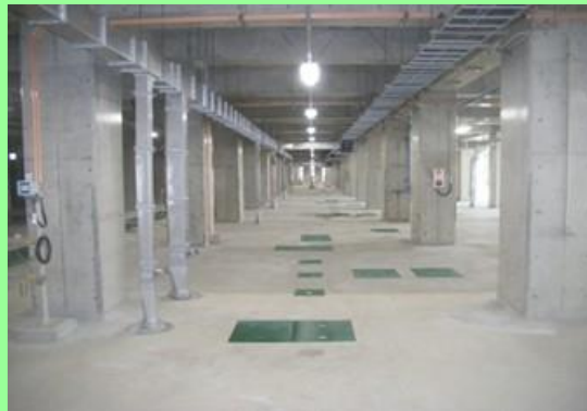
中部プラント改築後（反応槽）
