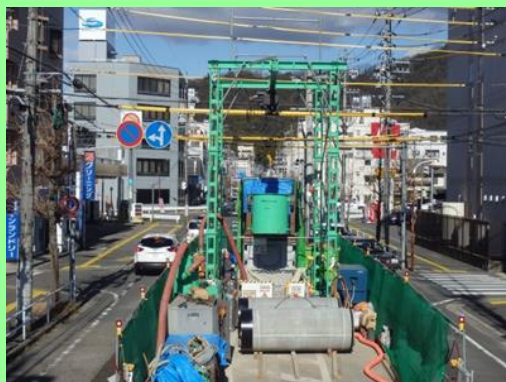
幹線の耐震化工事
