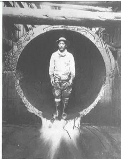
中部処理区下水幹線 (S9)
