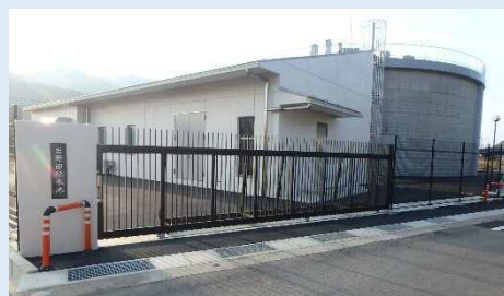
岩野田加圧施設
