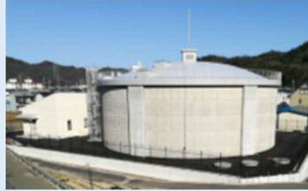
岩野田配水池
