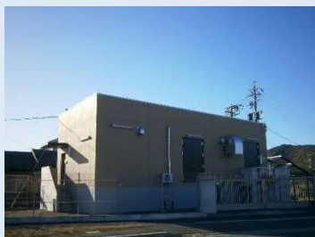
黒野第1加圧施設
