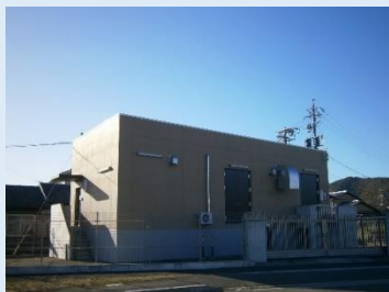
黒野第1加圧施設
