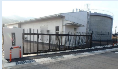
岩野田加圧施設
