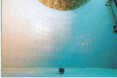
鏡岩配水池（内部）
