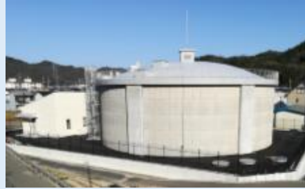
岩野田配水池
