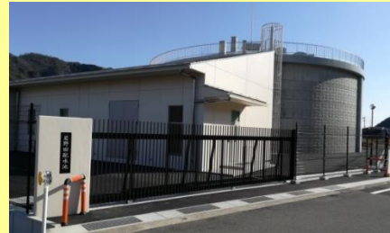
岩野田配水池 設置年度：平成29年
