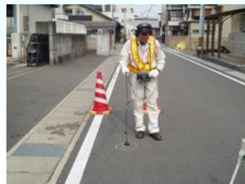
漏水調査（路面音聴調査）
