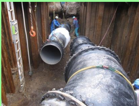
基幹管路の耐震化工事
