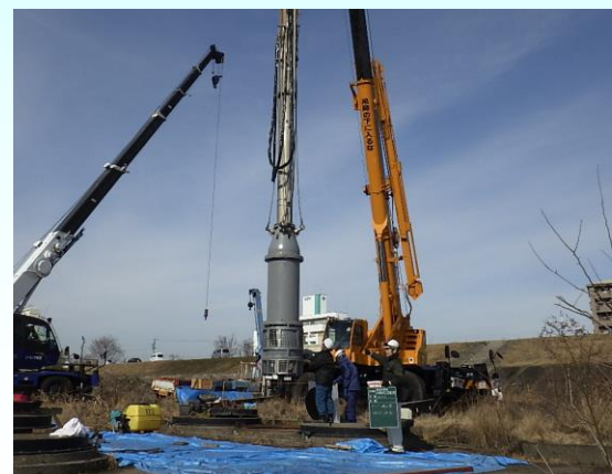
取水ポンプ取替状況 (雄総水源地)
