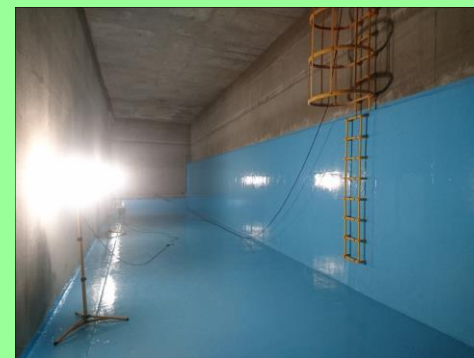
市橋配水池の耐震補強工事
