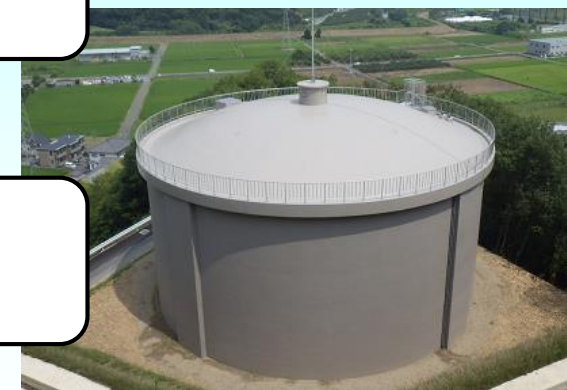
黒野第1配水池
