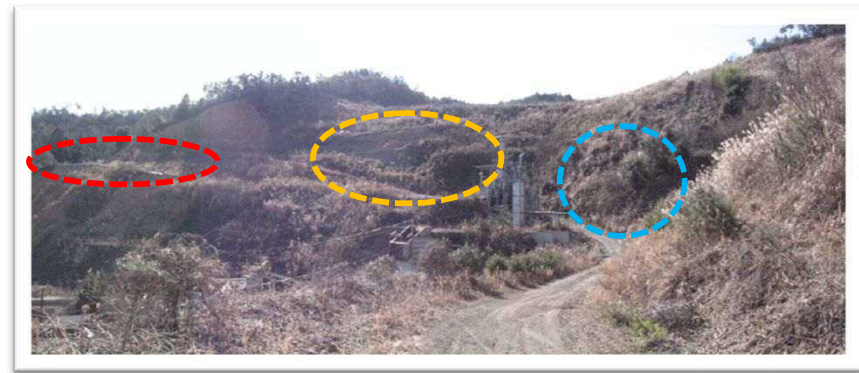
平成20年1月現場内より
