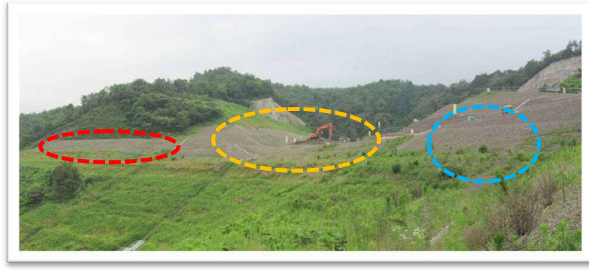
平成24年6月現場内より
