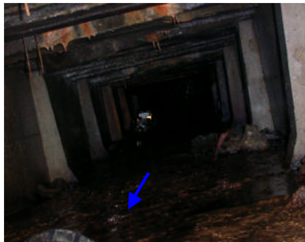
図 5.10 水路中間(撮影位置 )
