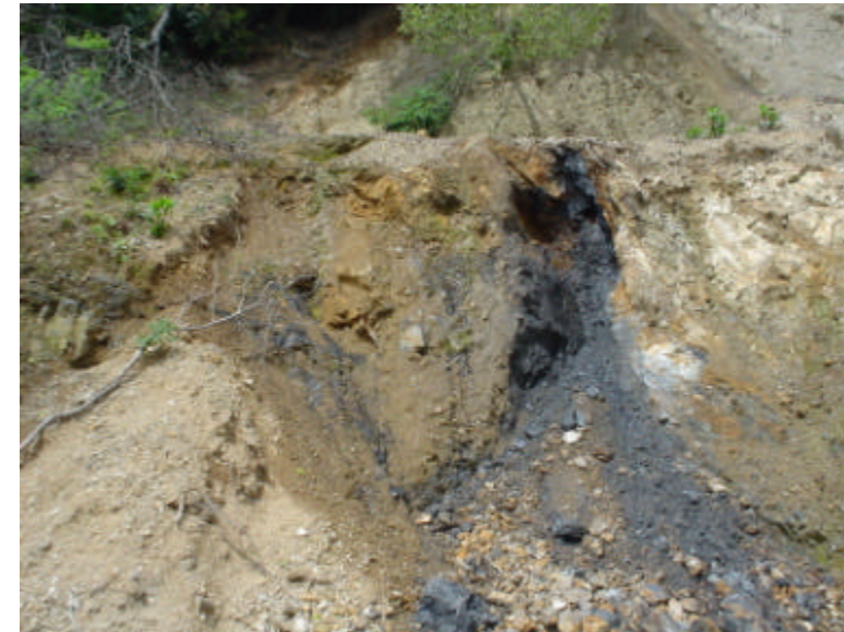
写真 断層破碎帯からの湧水
