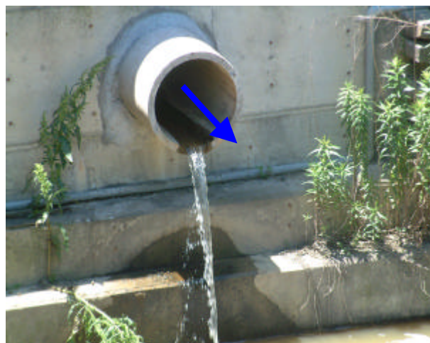
図 5.16 調整池流入(撮影位置 )
