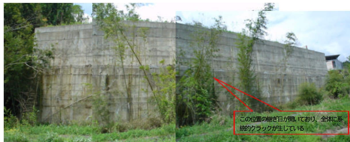
写真 擁壁状構造物の崩壊（崩壊前）
