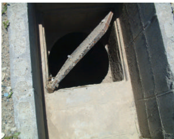
図 5.13 中間柵(撮影位置 )
