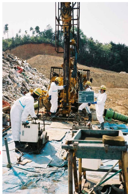
ボーリング調査の状況
