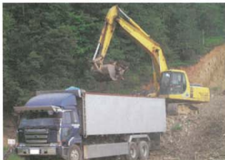
〈運搬車への積み込み作業〉
