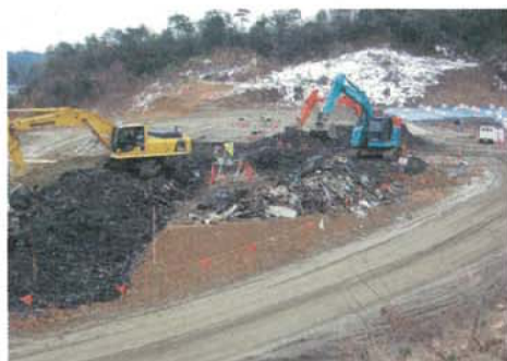
〈掘削状況(平成22年2月)〉
