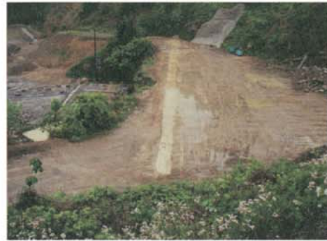
〈下流部止水壁施工終了時の状況〉
