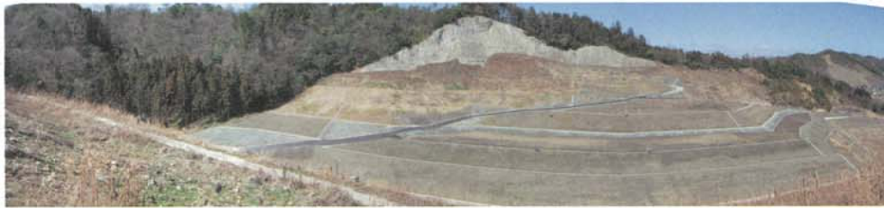
〈事業完了後の最上部の状況(平成25年3月)〉
