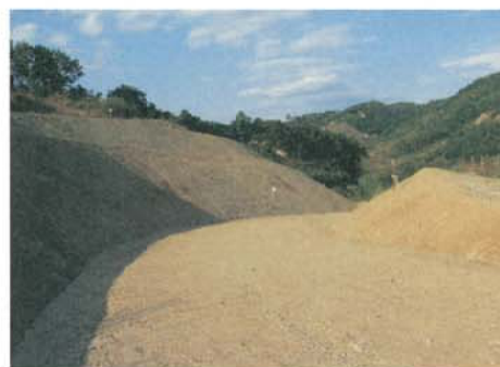
〈仮設道路(道路から北への眺望)〉
