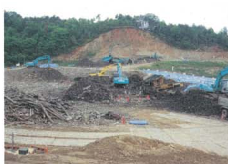
〈掘削状況(平成22年5月)〉
