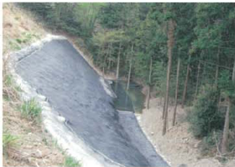
〈上流部止水壁設置直後の状況〉
