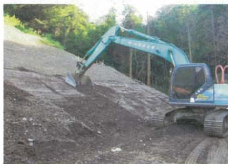
〈法面の覆土状況〉
