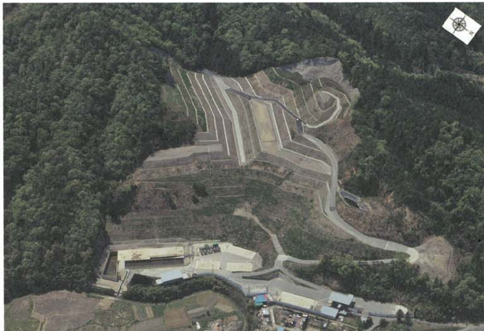
〈事業完了後の上空からの全景(平成25年4月)〉
