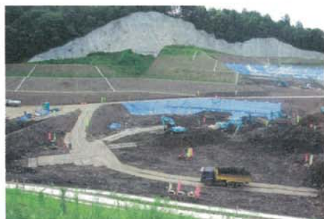
〈掘削状況(平成23年7月)〉
