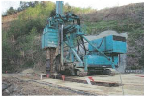
〈TRD施工状況〉
