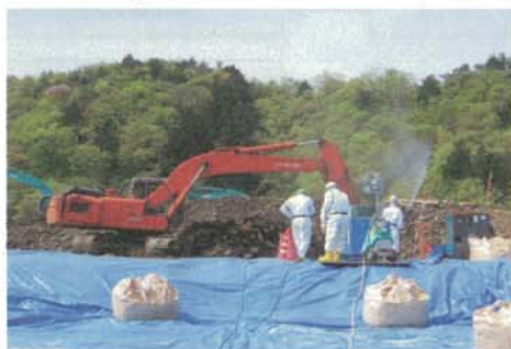
〈汚染廃棄物掘削状況〉
