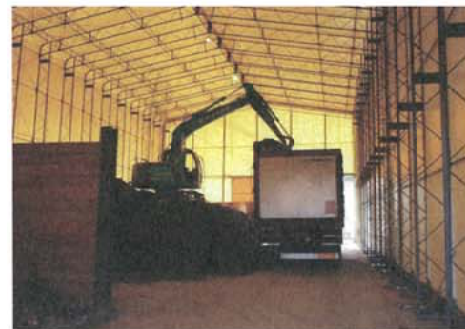
〈搬出物ストックヤード〉
