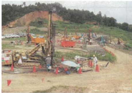
〈注水消火状況全景〉
