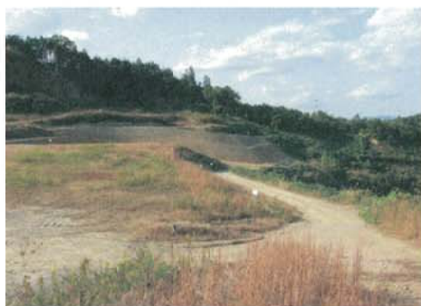
〈仮設道路(東からの眺望)〉
