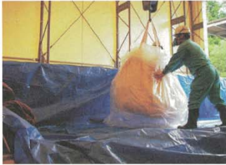
〈汚染廃棄物積込状況〉
