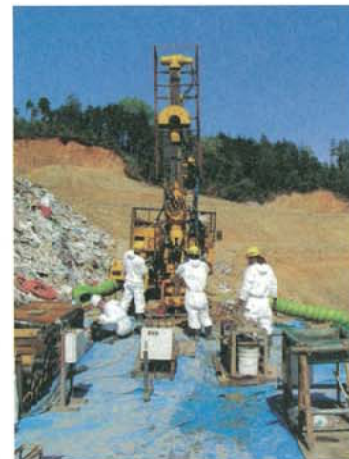
〈ボーリング作業状況〉
