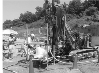
●注水機械(ロータリーパーカッションドリル)
