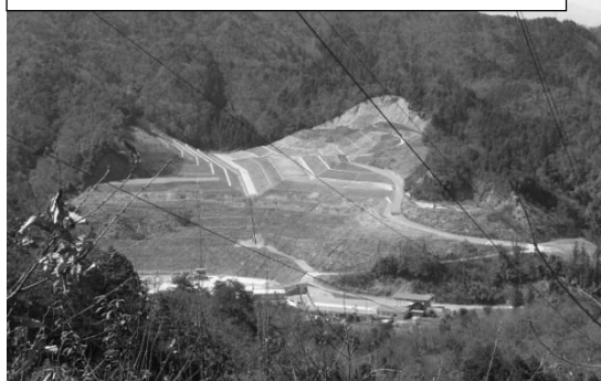
工事完了後の現地の様子(平成 25 年 3 月撮影)
